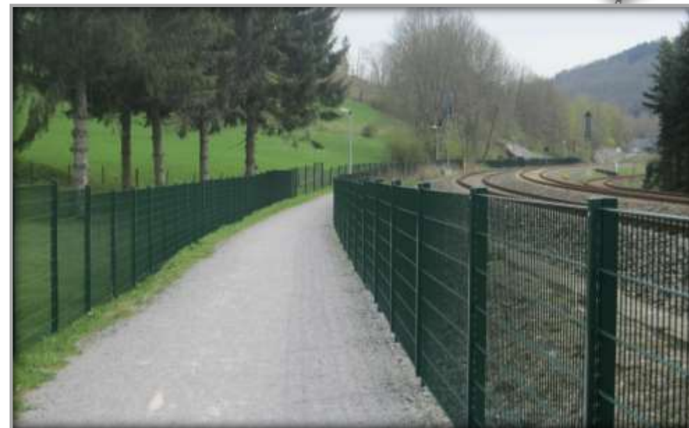
Sicherer Rad- und Fußweg mit umweltbewusster Oberflächenbefestigung
