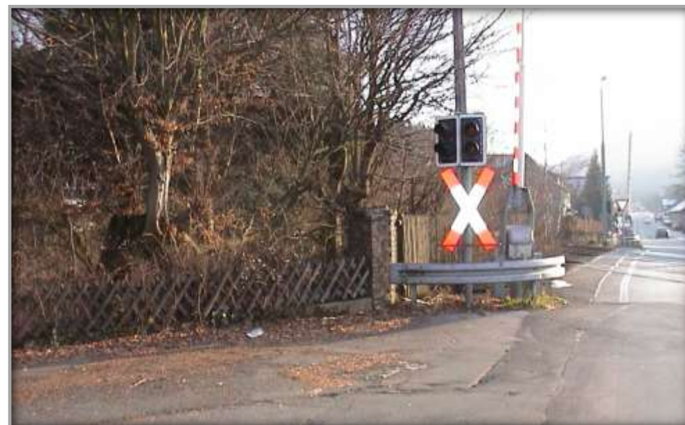
Unübersichtliche Kreuzung wegen dichter Vegetation
